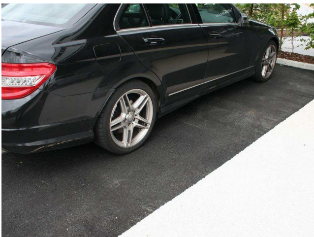
Schwarzer Bitumenbelag neben Belag aus Weiss- pigment Prox ® Titanweiss 100 und hellem Bindemittel
