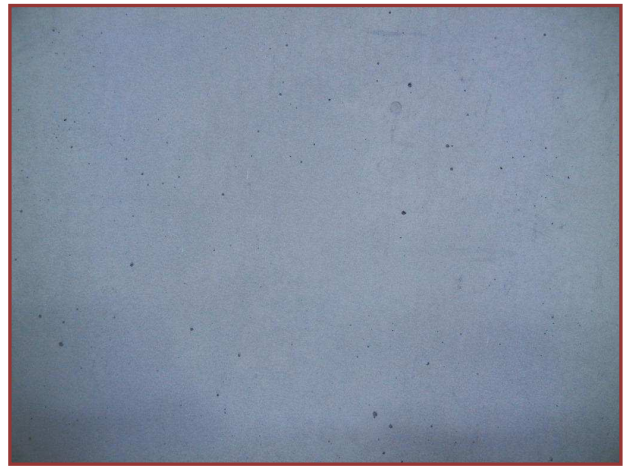
F. Detailansicht Wand rechts
